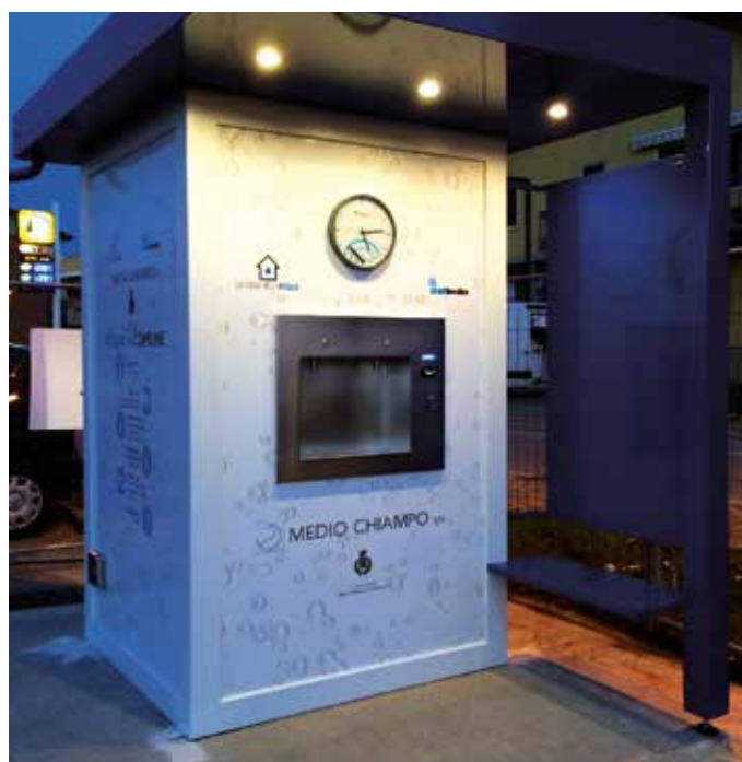
Casa dell'Acqua Mobile nel Comune di Montebello Vicentino (VI)
